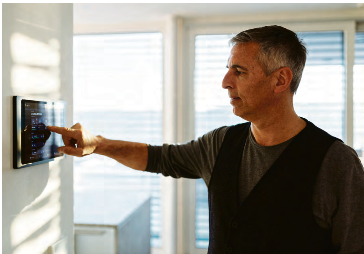
Intelligente Gebäudetechnik hilft, Licht, Klimaanlage, Jalousien, Sicherheitsanlagen oder Multimedia zentral zu steuern.
