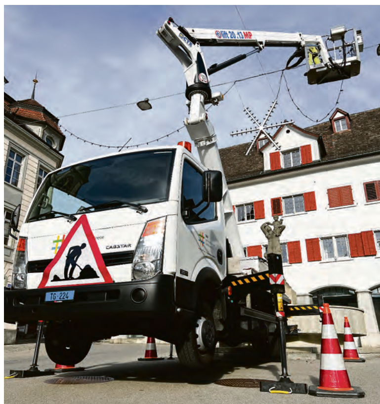
Mitarbeiter der Technischen Betriebe Weinfelden installieren die Sterne.
