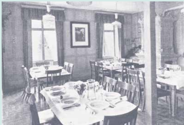
Esszimmer im Friedheim
