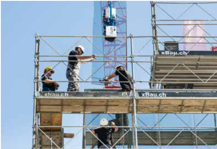
Ein Glaselement nach dem anderen wird an der Fassade montiert.
