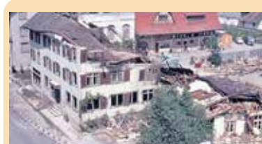
1968 Abbruch der Krone „Adieu la Couronne“
