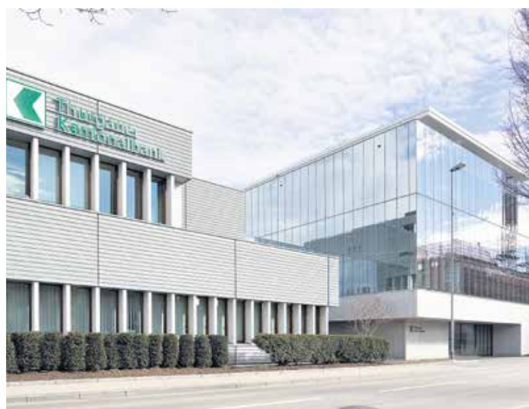
Der Erweiterungsbau mit der Glasfassade harmoniert mit dem Hauptsitz. Die beiden Gebäude sind durch eine Passarelle verbunden.
