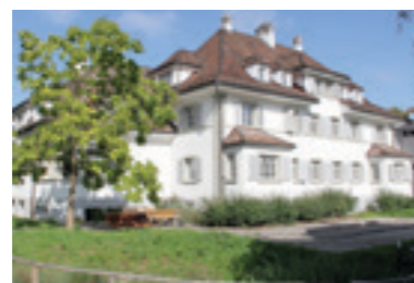
Stiftung Sonnenrain Zihlschlacht, Minergie Umbau
