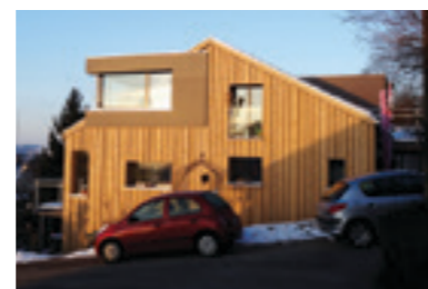
EFH Kappelerweg Weinfelden, Minergie Umbau
