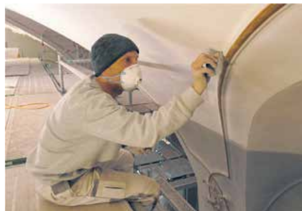
Die Wände erstrahlen nach der Trockenreinigung in der deutlich helleren Originalfarbe
