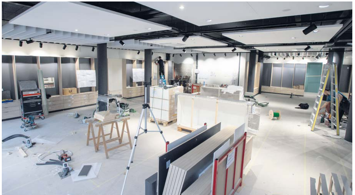
Mit den ersten Regalen nimmt der Laden langsam Gestalt an. Schon Fertig ist die Decke mit der Beleuchtung. Bilder: Mario Testa
