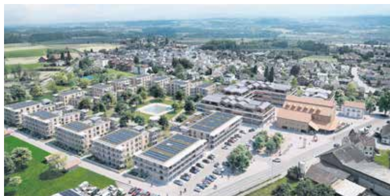
Der Coop in Berg soll auf dem Ziegelei-Areal direkt hinter der alten Ziegelei entstehen.
