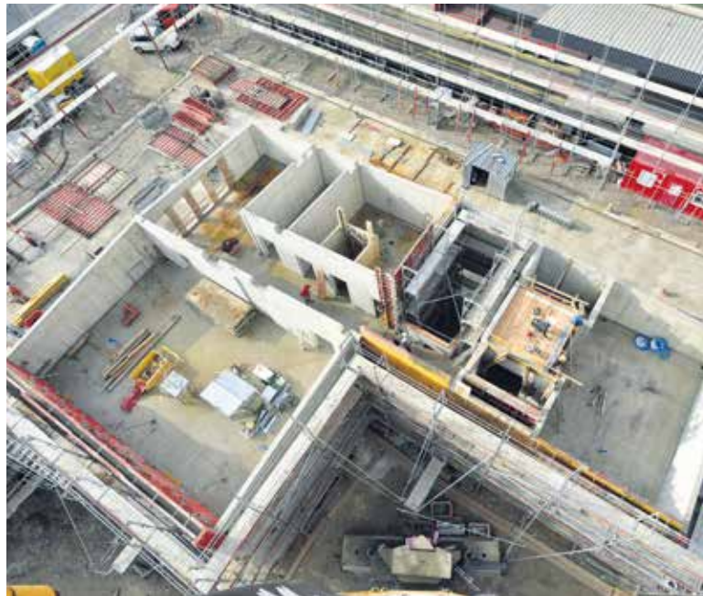
Bei ihren Bauprojekten achtet die Stadt auf den Einsatz von Recyclingmaterial.
