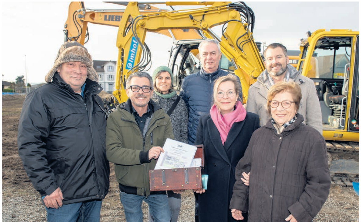
Beim Spatenstich: Kurt Ammann, Architekt Enrico Tocci, Jeannette Ammann jun., Christian und Jeannine Ballabio mit Jeanette Ammann sen. und Architekt Philipp Studer. Die Schatulle mit Bau- und Zeitdokumenten wird im Fundament vergraben.
