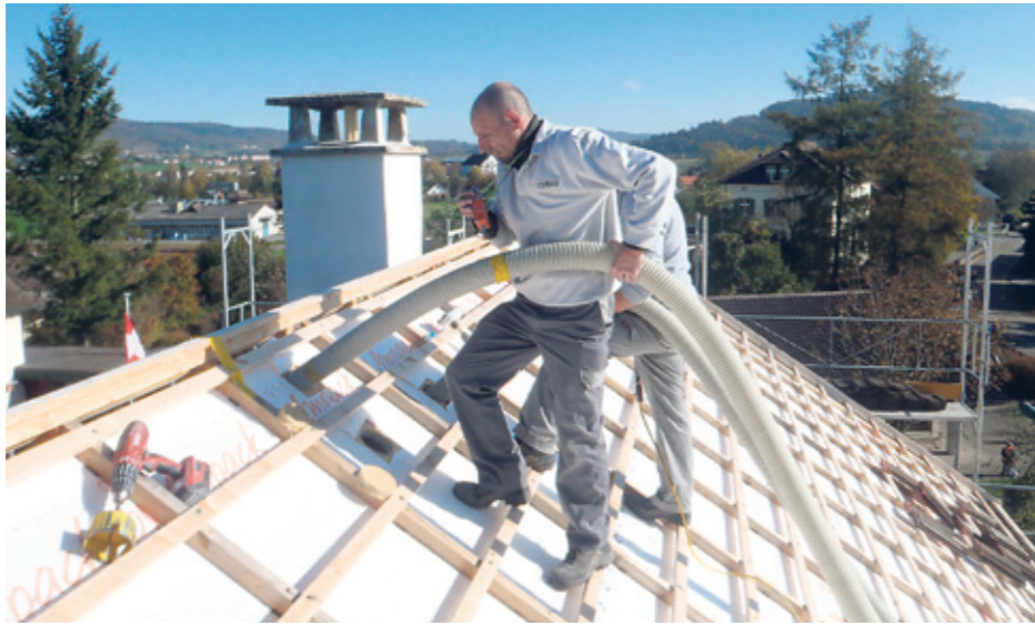
Dachdämmung
