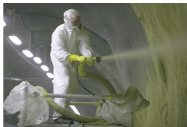
Arbeiten im Lötschberg
